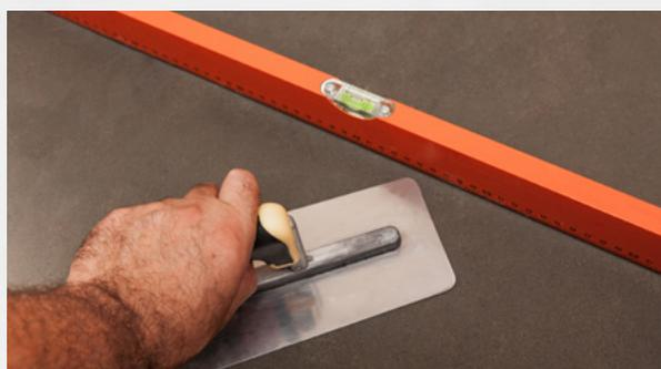
O contrapiso deve estar nivelado garantindo, assim, que o piso tenha maior superfície de contato com o contrapiso. Recomenda-se, também, que o contrapiso tenha uma pequena queda para que a água possa escoar. Como referência, nossos testes de colagem foram feitos em contrapisos com 3 partes de areia média para 1 parte de cimento e 2 partes de pedra.
